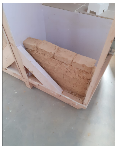
Construction de mur en briques de terre & paille (3è Habitat)
